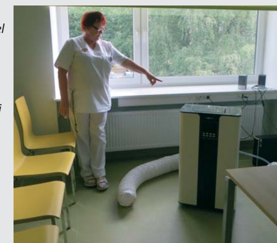
Nõuandla saali on veetud suur konditsioneer, mis peaks pakkuma lahendust pikalt kestnud ventilatsioonipro- bleemidele. Konditsioneeri jäme toru tuleb panna aknast välja ning aeg-ajalt tuleb tühjenda- da aparaadi taga olevat vee- paaki, mis õhu jahutamise- ga kiiresti täitub. Vanemämmaemanda Heli Rannu püüded konditsioneeri tööle panna esialgu tulemusi ei andnud.
